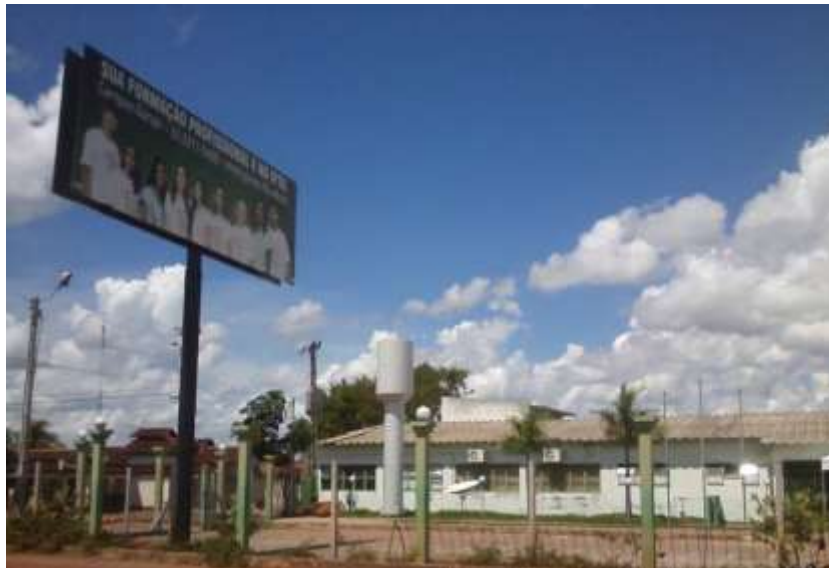
Figura 01- Fachada do IFTO - Campus Gurupi
